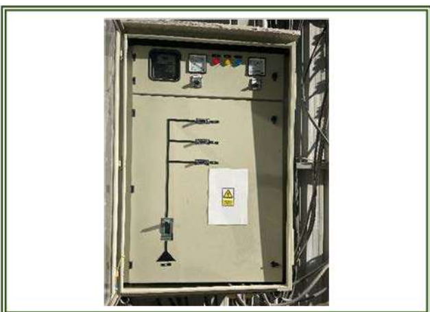
รูปที่ 2-36 สวิตช์ตัดวงจรไฟฟ้า
